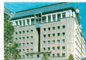
●鹿児島県庁舎警察棟
